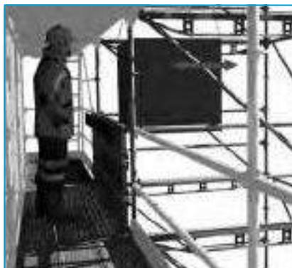
Le plancher rabattable de profondeur 1 m s'adapte à toutes les dimensions de sapines.
