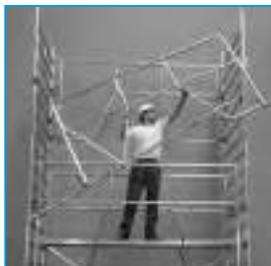
**Le garde-corps de sécurité est mis en place par un seul monteur, d'un côté, puis de l'autre.**
