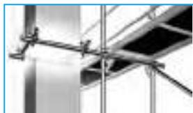
**d) ISOL-EX****Fixation de l'ancrage dans le cas
