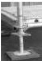
*N.B. Pas de nécessité de clouer les socles sur les cales EKISTACK : l'antiglisement est assuré par la conception de la cale.*
