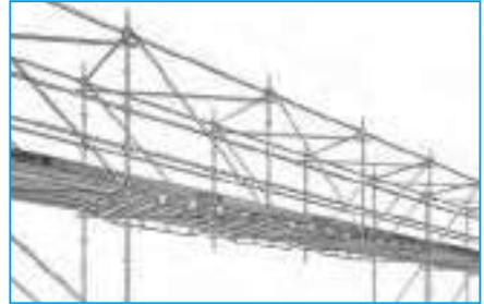
Pour suppléer aux poutres treillis, et pour des portées plus importantes, on reconstitue des **poutres Universel** avec moises et diagonales.
