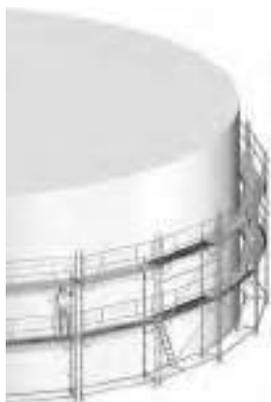
La mise en place de garde-corps de sécurité "nouvelle génération" assure la protection des monteurs à tout instant.
